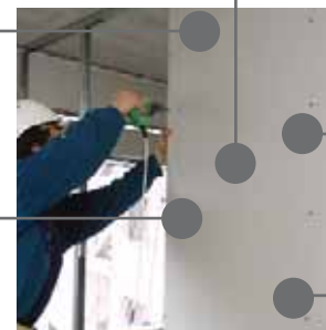
pladurrezko trenkada (Igeltso laminatuzko xaflak eta barne egitura metalikoa)
