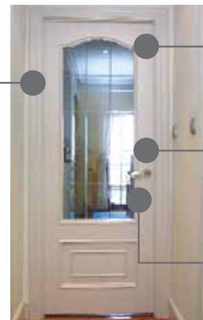
pladurrezko trenkada (Igeltso laminatuzko xaflak eta barne egitura metalikoa)
